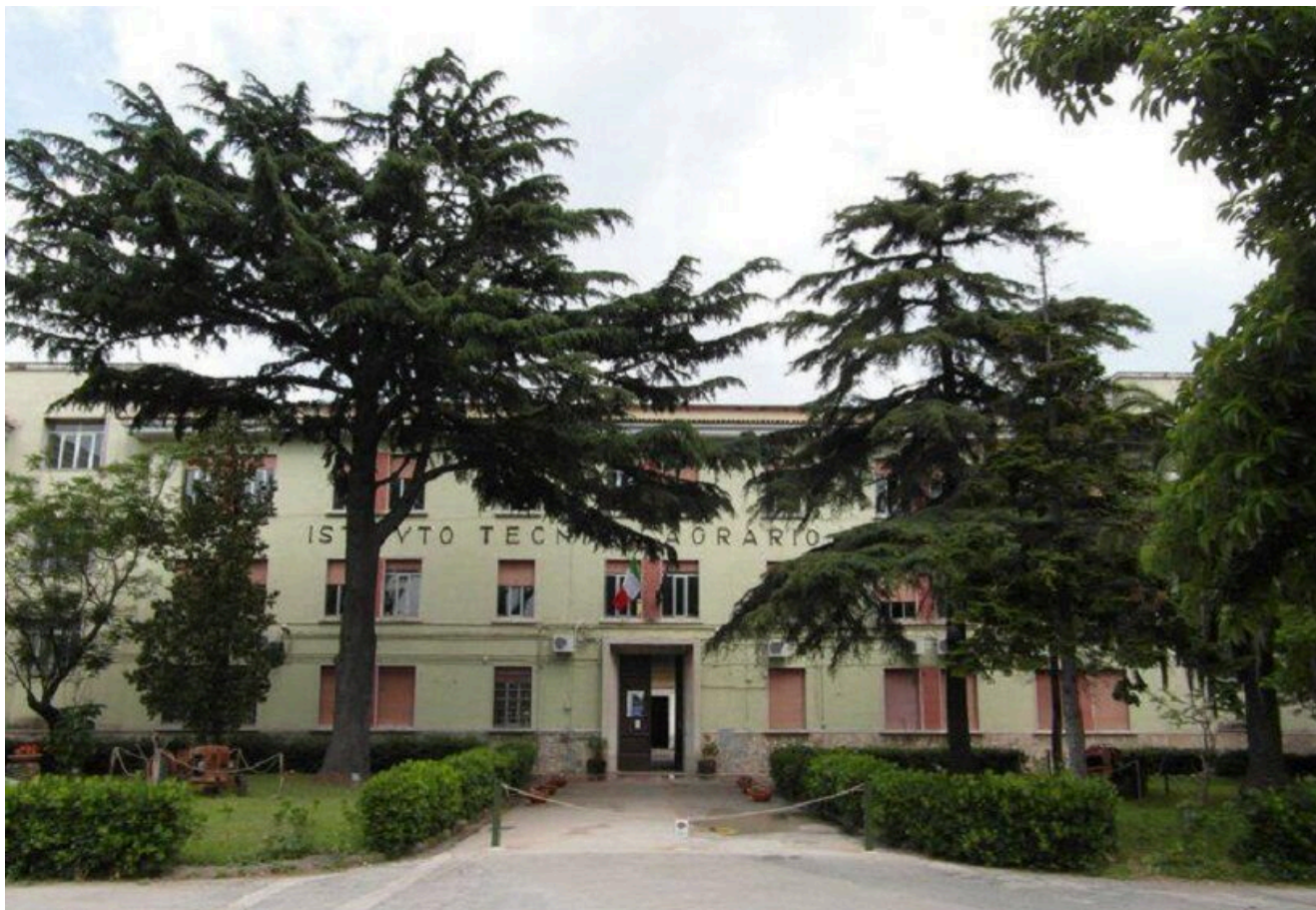
La sede dell'Istituto "De Cillis" Napoli-Ponticelli
