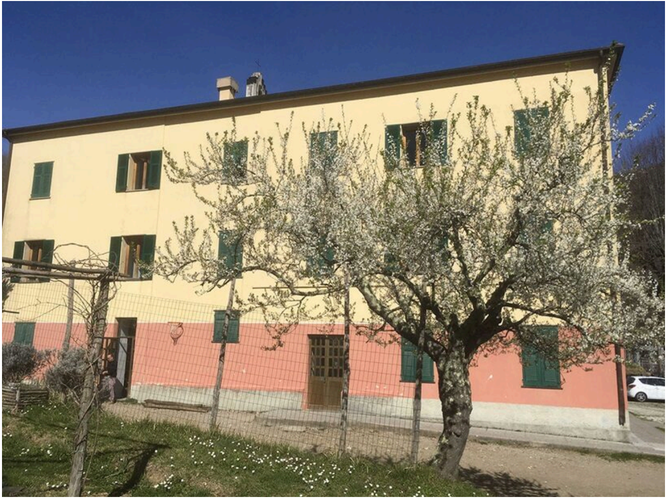
Sede San Colombano
