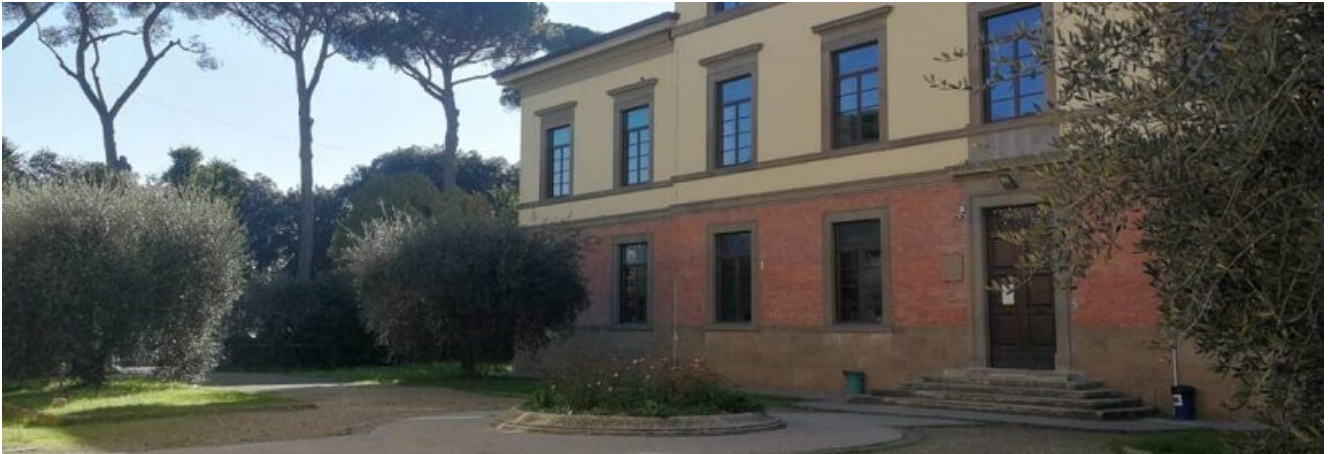
Edificio 1 dell'Istituto Tecnico Agrario di Firenze
