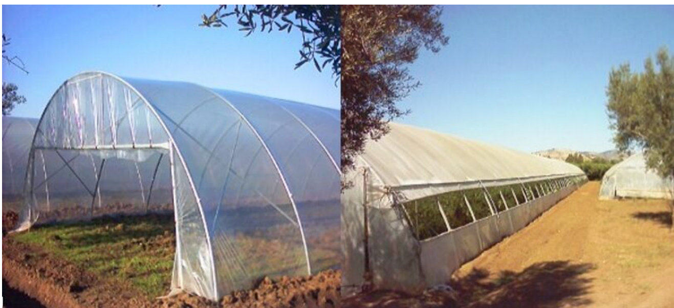
Serre a tetto curvilineo a sezione circolare
