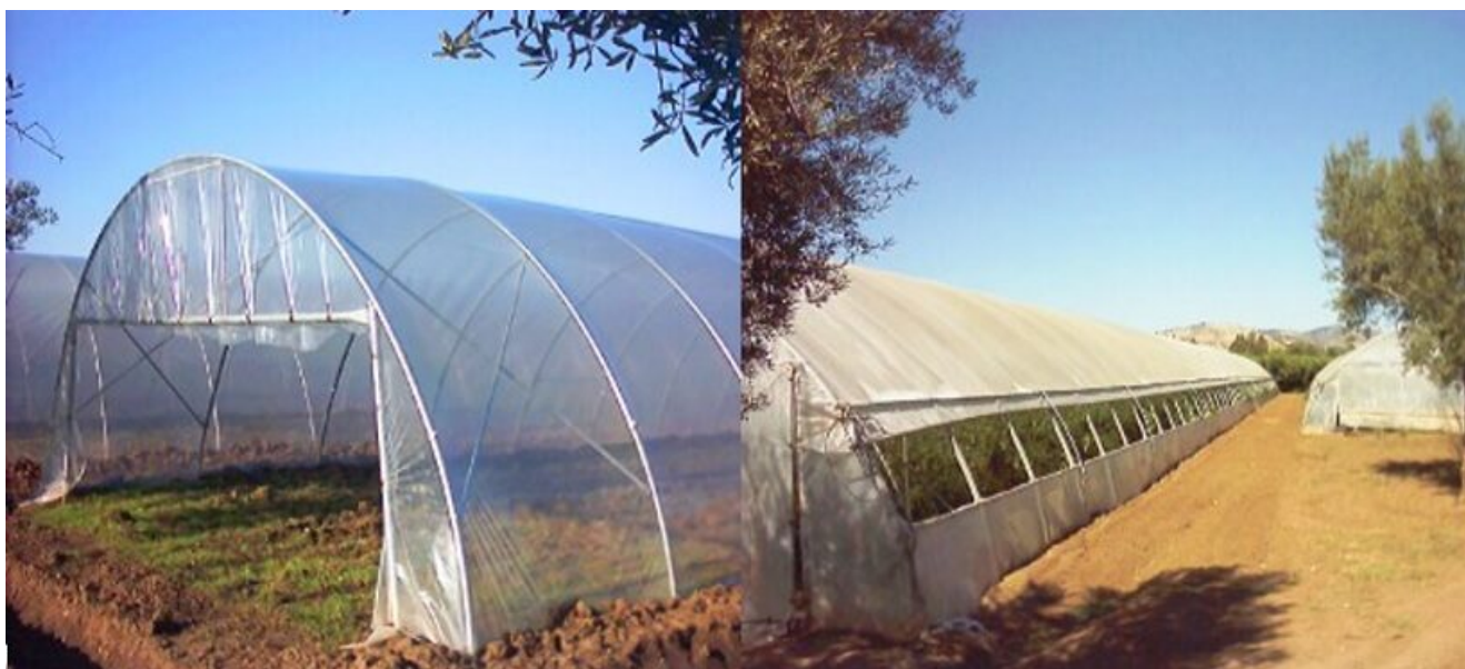
Serre a tetto curvilineo a sezione circolare
